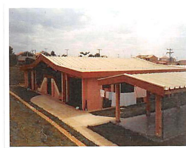
ESCOLA MUNICIPAL – AMERICANA – SP Estrutura e esquadrias metálicas 95 ton.
