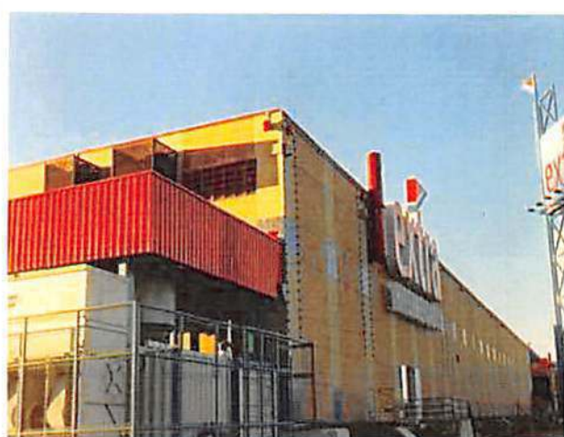
HIPERMERCADO EXTRA ARARAQUARA - SP Estruturas e esquadrias metálicas 95 ton.
