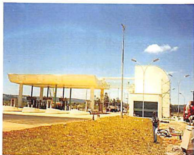
PEDÁGIO DE BROTAS – LIX DA CUNHA Estrutura completa do pedágio 60 ton.
