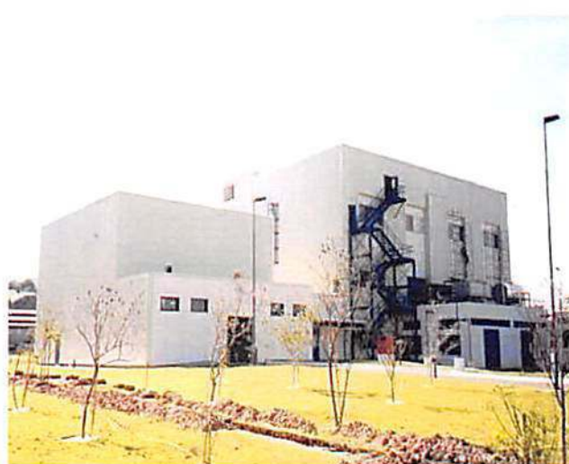
LABORATÓRIO ROCHE - SP Estruturas e esquadrias metálicas 115 ton.
