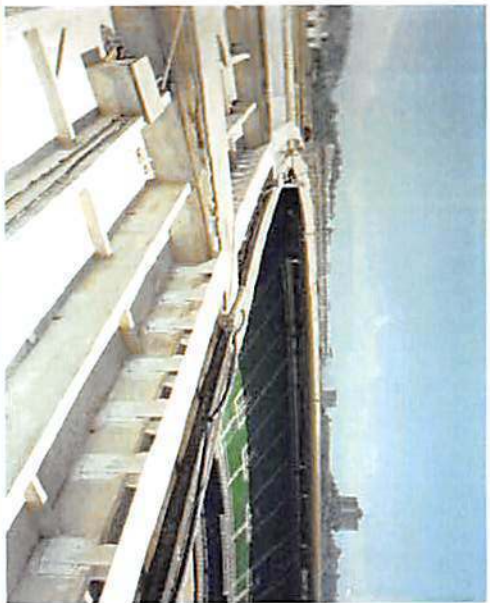
COMPLEXO DO MARACANÃ – RJ Passarela, mezaninos metálicos 285 ton.
