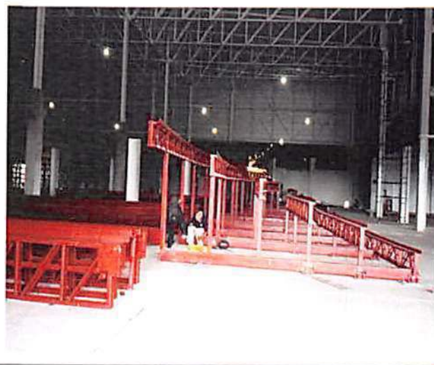
CINEMA Estruturas metálicas para arquibancada 79 ton.
