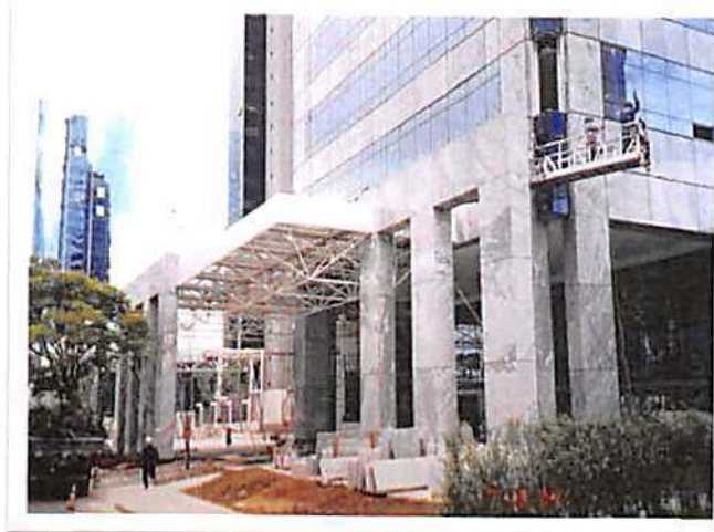
PLAZA I – SP Marquise, pórticos, estrutura para pele de vidro e esquadrias metálicas. 87 ton.
