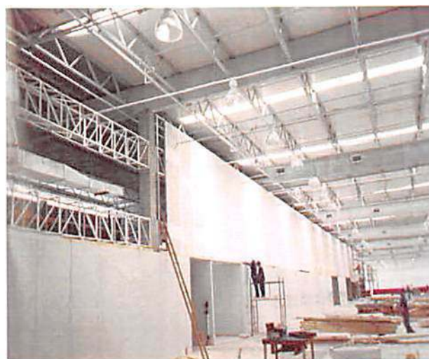
HIPERMERCADO EXTRA SÃO MIGUEL PAULISTA Estruturas e esquadrias metálicas 88 ton.
