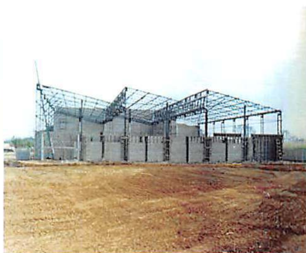
CONCESSIONÁRIA CHEVROLET – SALTO Cobertura metálica, mezaninos e esquadrias metálica
