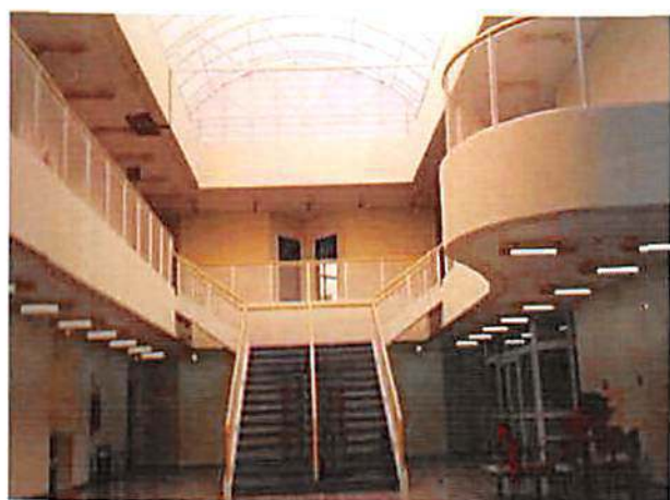
ESCOLA CULTURA INGLESА – CAMPINAS Cobertura, escadas e esquadrias metálicas 70 ton.
