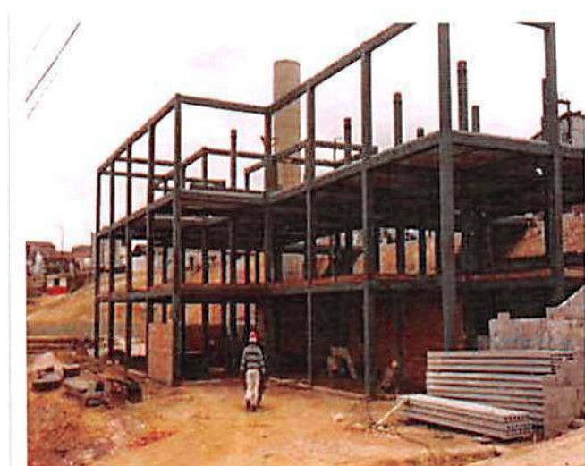
ESCOLA – TUCURUVI – SP Edifício metálico 76 ton.
