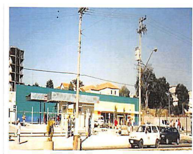
SUPERMERCADO CHAMPION – CAÇAPAVA Estruturas e esquadrias metálicas 53 ton.
