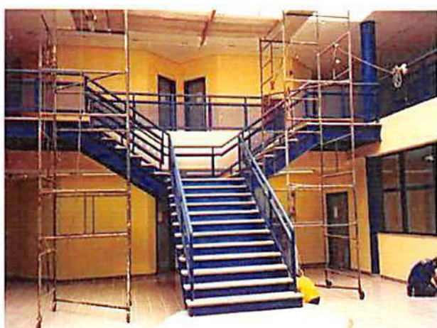
CULTURA INGLESА – BELENZINHO Cobertura, escadas e esquadrias metálicas 72 ton.
