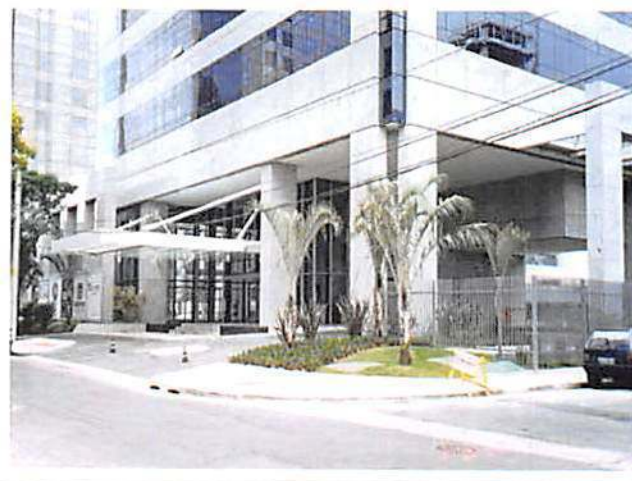
PLAZA II – SP Marquise, pórticos e esquadrias metálicas 75 ton.
