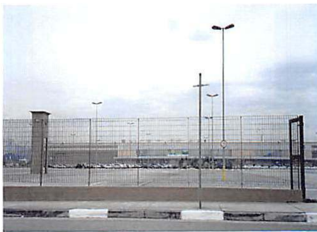
TRANSAMÉRICA EXPO CENTER – SP Passarelas e esquadrias metálicas 110 ton.
