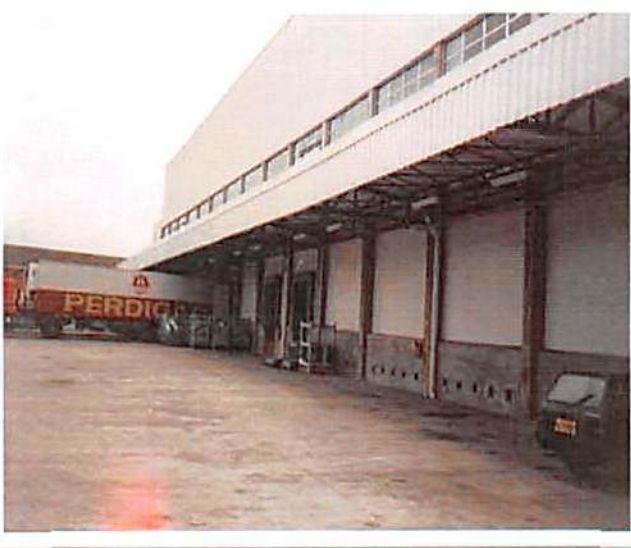
PERDIGÃO – SP Estrutura e esquadrias metálicas 48 ton.
