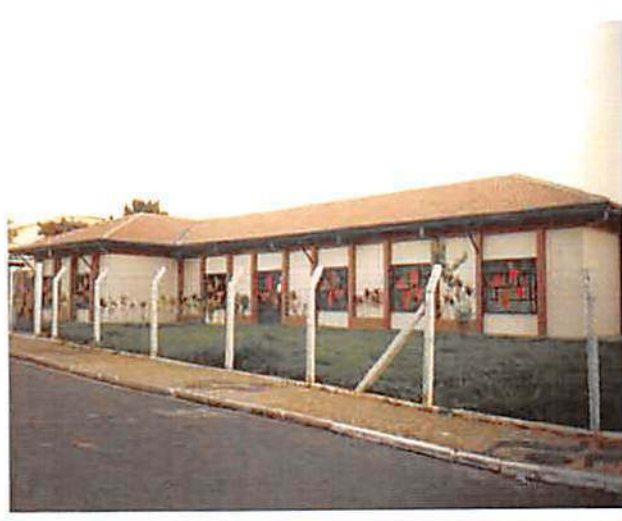
ESCOLA MUNICIPAL – AMERICANA – SP Estrutura e esquadrias metálicas 98 ton.
