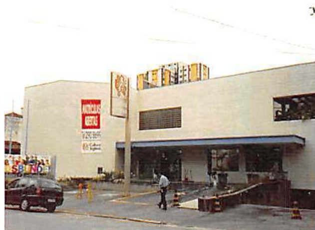
CULTURA INGLESА – GUARULHOS Estruturas e esquadrias metálicas 68 ton.
