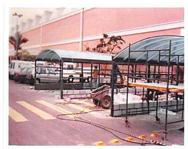
EXTRA – SANTO ANDRÉ Estruturas e esquadrias metálicas 38 ton.
