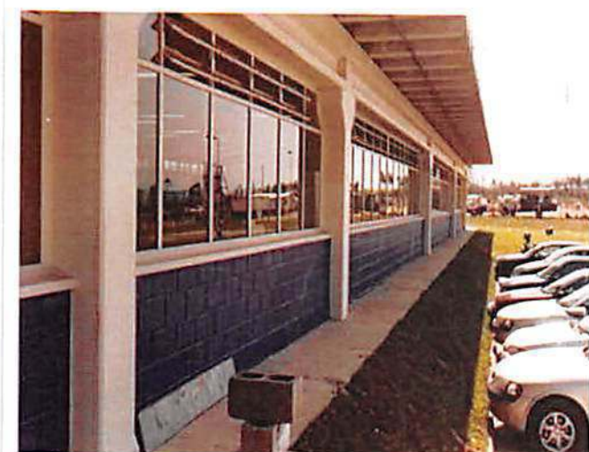
YUDIGAR DO BRASIL – JUNDIAÍ Esquadrias metálicas 38 ton.
