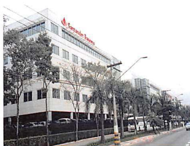
PANAMÉRICA – SP Estrutura e esquadrias metálicas 95 ton.
