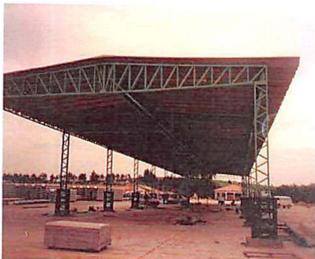
ETERBRÁS – CAPIVARÍ – SP Estrutura metálica 25 ton.
