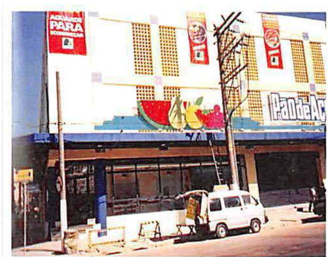
SUPERMERCADO PÃO DE AÇÚCAR – PEDROSO Estruturas e esquadrias metálicas 29 ton.
