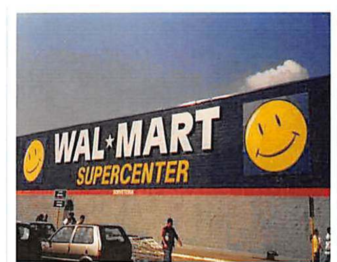
HIPERMERCADO WAL MART – OSASCO – SP Estruturas e esquadrias metálicas 82 ton.
